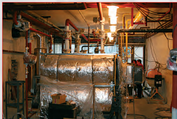
ACSS spol. s r.o. Bratislava: Nízkotlaká teplovodná plynová kotolňa. Nízkotepelné kondenzačné kotle Froling, horáky pretlakové Weihaupt a automatika MaR Siemens PRU.
